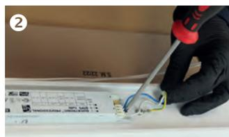
Zuleitungen und Kabel abtrennen und bestehendes Vorschaltgerät demontieren.
